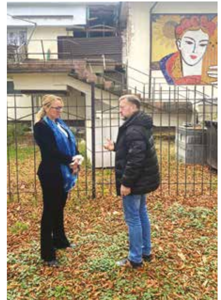
Taras Dydycz pokazuje ogrom zniszczenia budynku Rady Gminy oraz Centrum Kultury w Dmytriwce.
