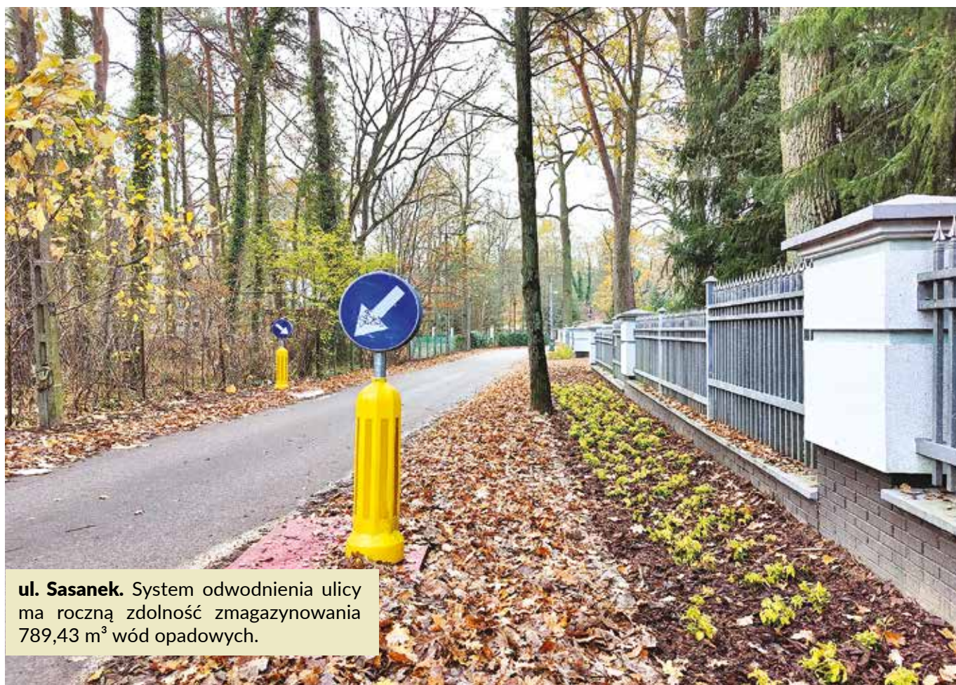
ul. Wróbla. System odwodnienia ulicy ma roczną zdolność zmagazynowania 1413,60 m 3 wód opadowych.
