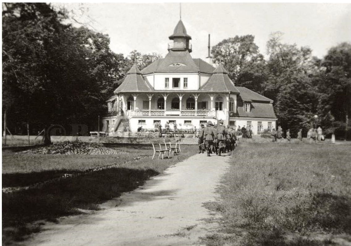
44. Budynek Klubu Sportowego w parku miejskim w Podkowie Leśnej od strony wschodniej w 1942 r. Podpis: Waldkafee. Widoczne zachowane zagospodarowanie terenu z okresu międzywojennego.
